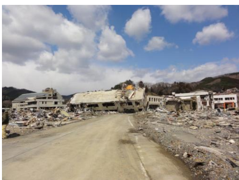
写真-1 鉄筋コンクリート建物の被害
