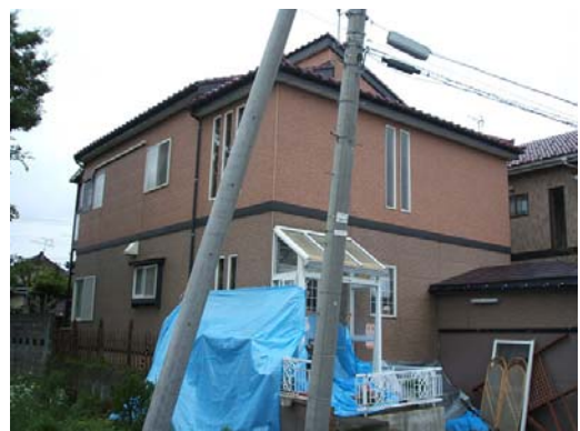
写真-2 新潟県中越沖地震(2007)による木造建物の被害
