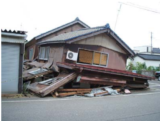
写真-1 新潟県中越沖地震(2007)による木造建物の被害
