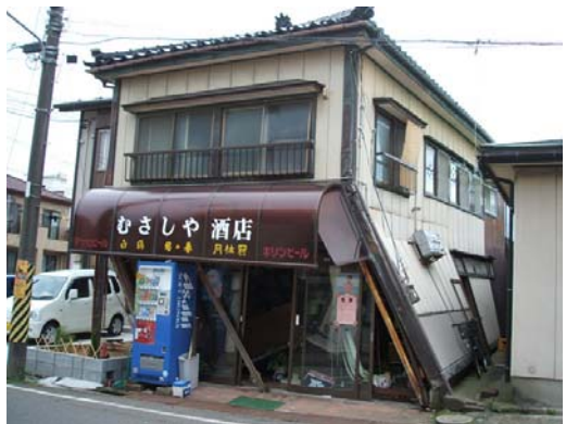
写真-1 新潟県中越沖地震(2007)による木造建物の被害
