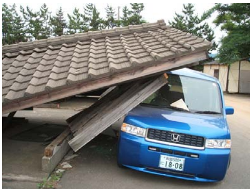
写真-2 新潟県中越沖地震(2007)による木造建物の被害
